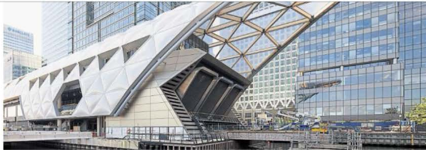
Drei österreichische Firmen waren am Bau des Dachs der Londoner Canary Wharf Crossrail Station beteiligt.
